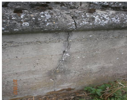
4 – Оштећење зида на месту продора, небрањена страна
