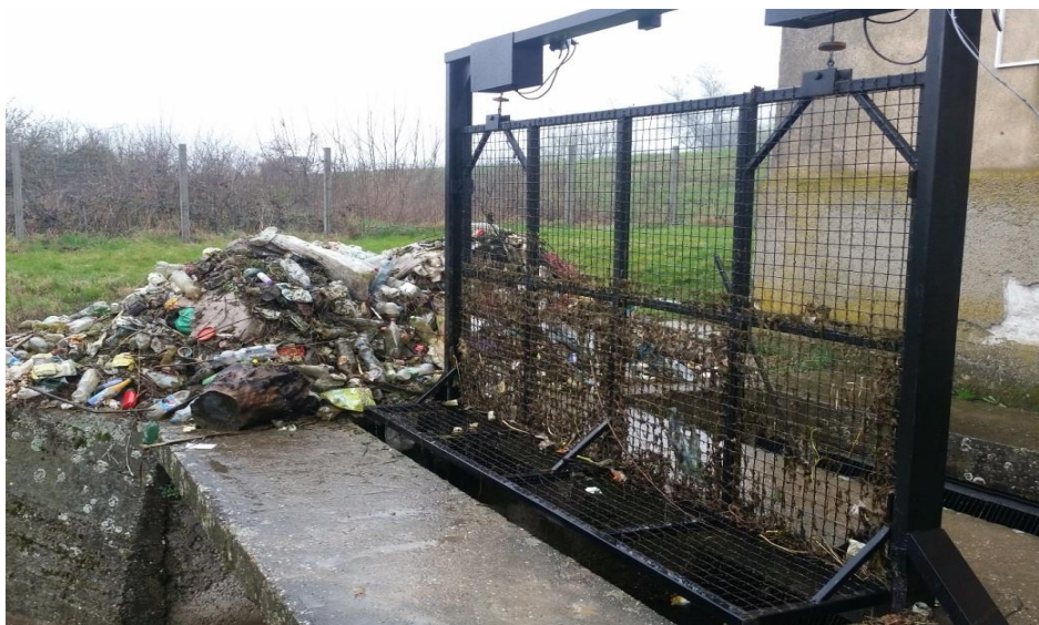
Слика 11. Последице поплаве на доводном каналу Дреновац
