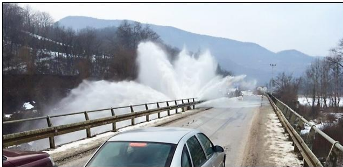
Слика 10. Хаварија на краку за Лучане магистралног ценовода водосистема „Рзав“ – мост преко Западне Мораве код Кратовске стене (25.01. 2016.)
