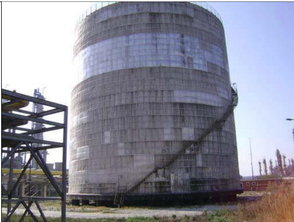
Слика 11. Резервоар амонијака ФБ-3001
