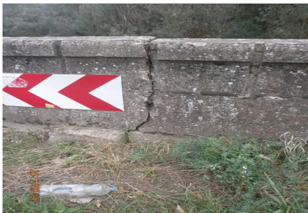
3 – Оштећење зида на месту продора, брањена страна
